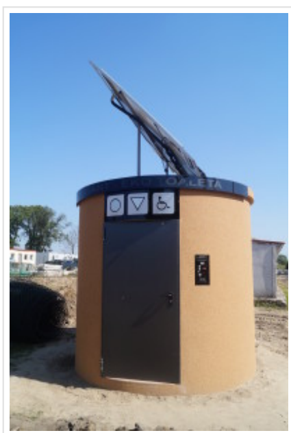
Toaleta z kolektorem słonecznym i modułem fotowoltaicznym
